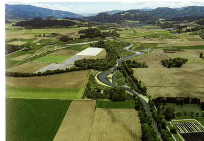
Abbildung 2: Maßnahmenbereich „Laufverschwenkung Lavant“ als Fotomontage im Vordergrund, im Hintergrund der im Zuge der ÖBB-Maßnahme geschaffene, neue Verlauf der Lavant
