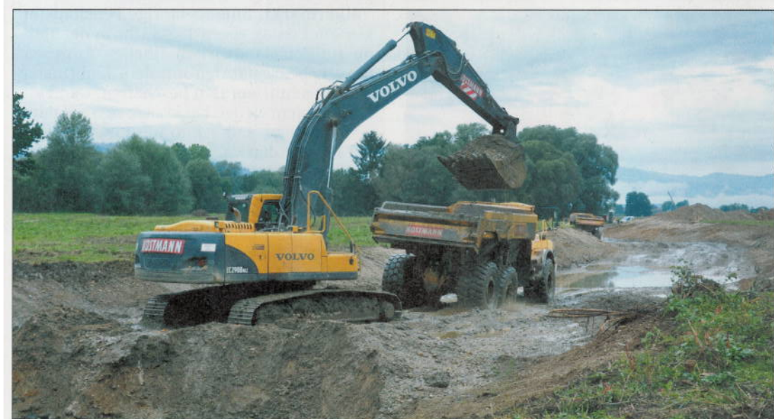
Mit schwerem Gerät wird am künftigen neuen Flussbett der Lavant gearbeitet
