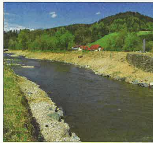
Die Sinuidalschwelle Altach wurde gänzlich entfernt. Flussauf der Schwelle wurde das Flussbett neu strukturiert und bietet nun einen vielfältigen Lebensraum. Mit der Entfernung der Schwelle wurde die erste Barriere flussauf der Lavant-Mündung in die Drau beseitigt. Ein Paradebeispiel für die umgesetzten Tätigkeiten. Fotos: Umweltbüro GmbH
