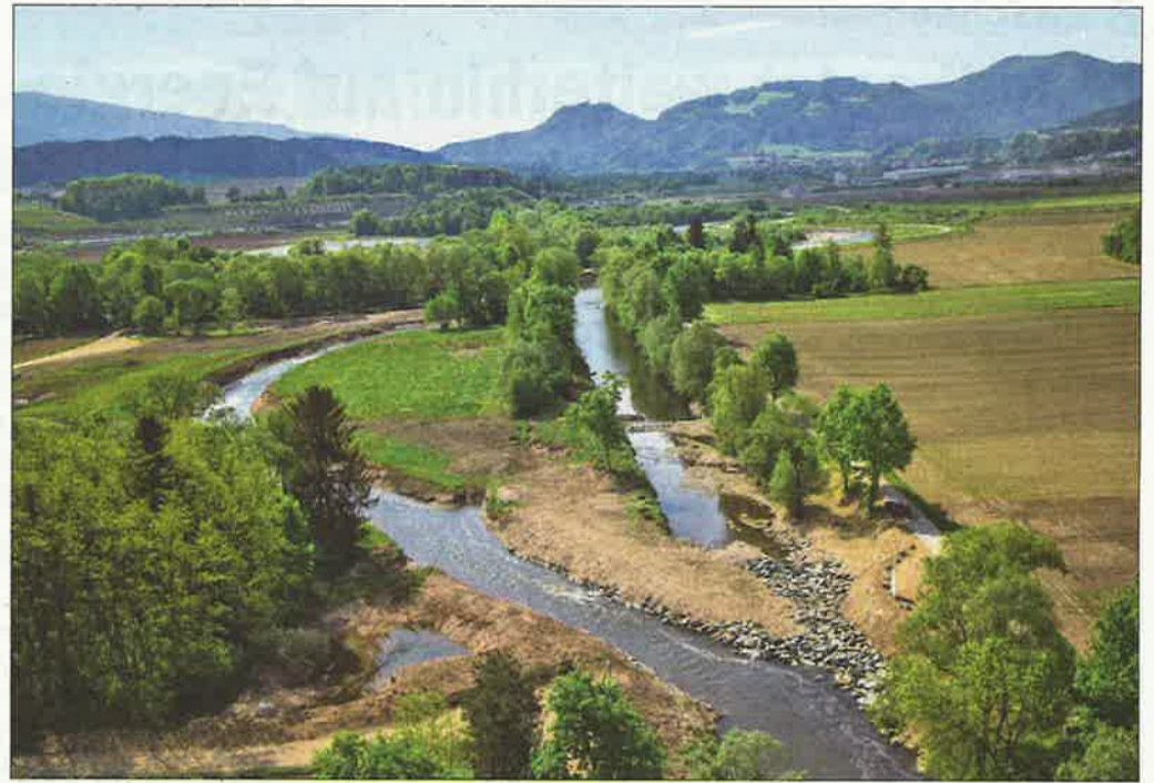
Laufverschwenkung Lavant Mettersdorf: Durch den Bau des neuen Flusslaufs wird die bestehende Lavant-Sohlstufe umgangen, die Fische können hier auf rund 400 Metern in einem neuen, strukturreichen und dynamischen Flussabschnitt barrierefrei wandern.
