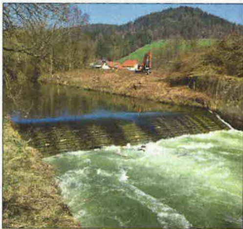
Die Sinuidalschwelle Altach wurde gänzlich entfernt. Flussauf der Schwelle wurde das Flussbett neu strukturiert und bietet nun einen vielfältigen Lebensraum. Mit der Entfernung der Schwelle wurde die erste Barriere flussauf der Lavant-Mündung in die Drau beseitigt. Ein Paradebeispiel für die umgesetzten Tätigkeiten. Fotos: Umweltbüro GmbH
